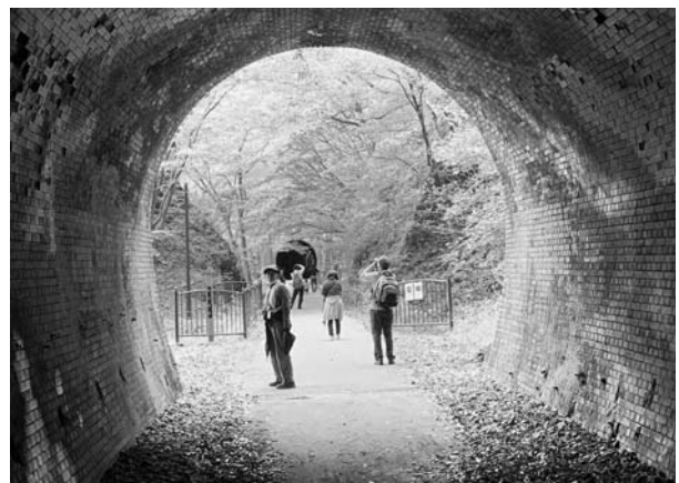
碓氷第一トンネル
